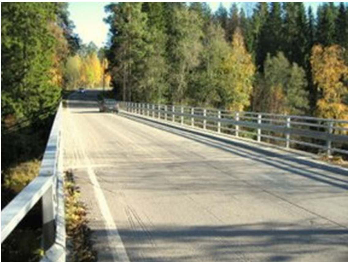
Tuttu näkymä Tunkkarin sillalta. Kuva: Hannu Salo.
